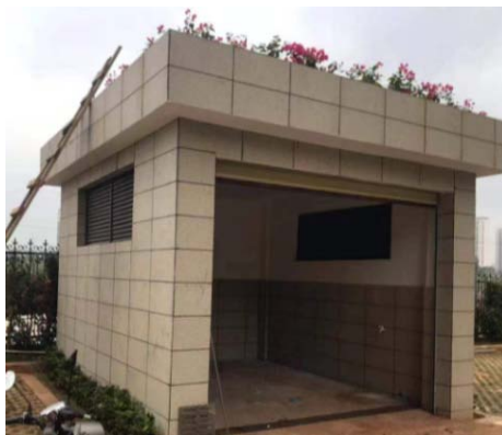
项目生活垃圾收集房
