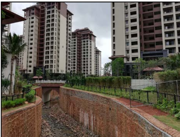
那甲河项目河段护岸工程
